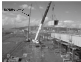
監視用クレーン 牧野大橋右岸側(TC架設)▶P.33
