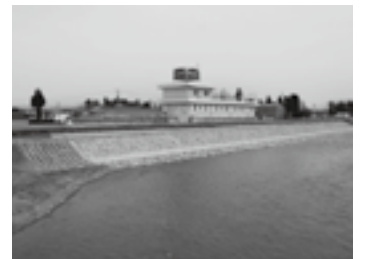
熊野川護岸工事▶P.51
