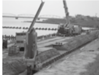
鋼矢板圧入工法の施工状況▶P.4
